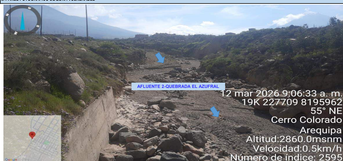
Imagen N° 1. Tramo colmatado de piedras pequeñas en el sector villa Cerrillos-Fundo Cabrerías, en donde se observa sedimentación en el cauce del Afluente 2 de la quebrada El Azufral.
